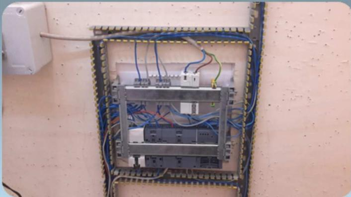
Iniziare a fare i collegamenti della bassa tensione, nello specifico quelli del PLC
